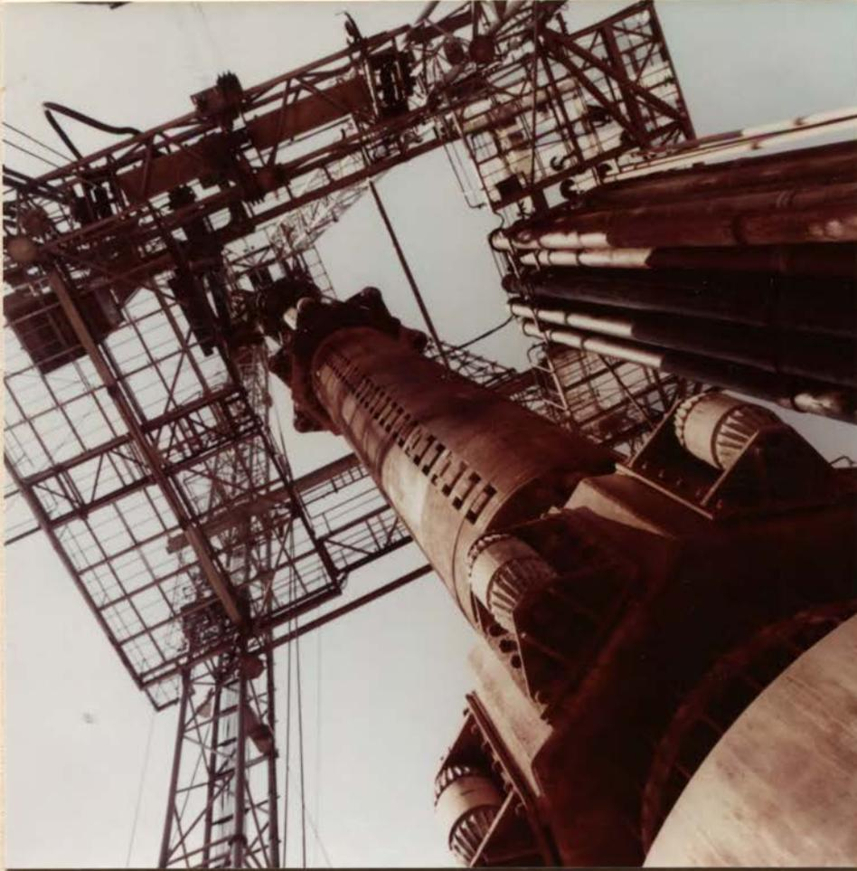
Großbohrgeräte mit einem nutzbaren Schachtbohrdurchmesser von 3 m zur Abteufung von Schachanlagen des Bergbaues gehören zur Vielfalt der wissenschaftlich-technischen Leistungen des VEB Schachtbau Nordhausen.
