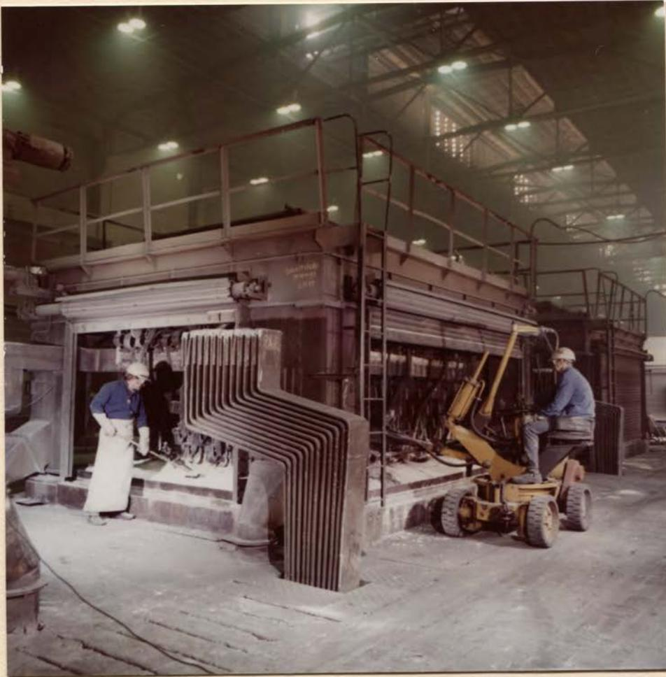
In der Aluminium-Schmelzflußelektrolyse im VEB Aluminiumwerk Lauta wird aus Ton-
