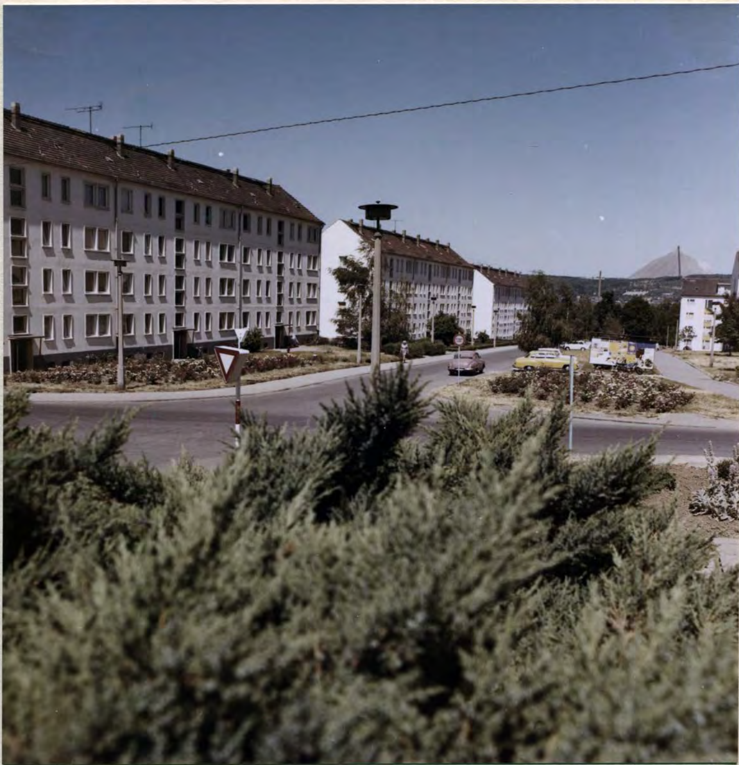
30 Jahre Deutsche Demokratische Republik sind 30 Jahre Sorge um das Wohl der Werktätigen: Moderne Wohnungen für die Werktätigen des Kombinates wurden auch in der Bergarbeiterstadt Sangerhausen gebaut.
