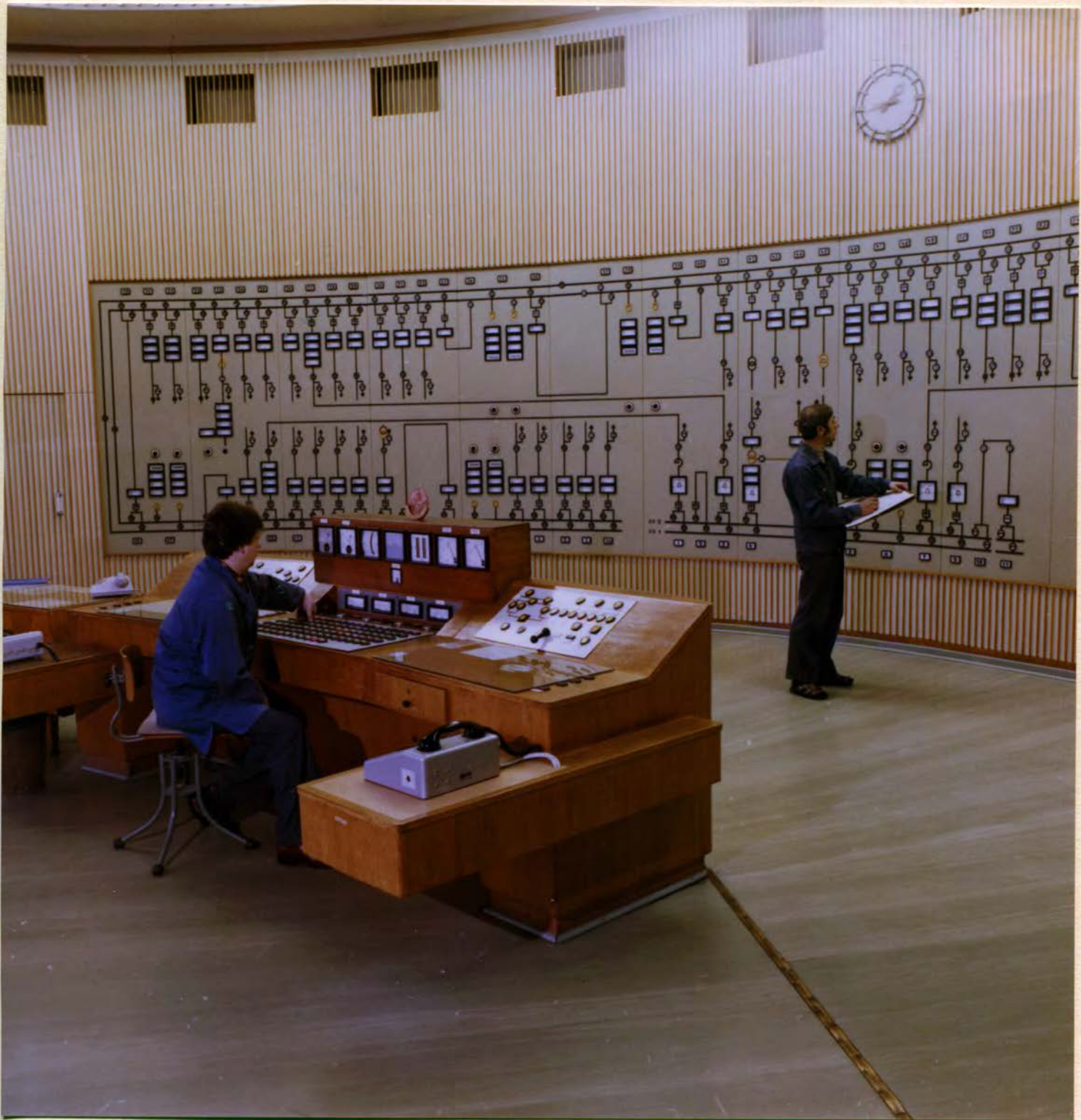
Vollautomatisch gesteuerte Anlagen garantieren nicht nur eine hohe Qualität des von uns erzeugten Kupfers, sondern verbessern auch die Arbeitsbedingungen: Blick in eine Zentrale zur automatischen Steuerung metallurgischer Prozesse.
