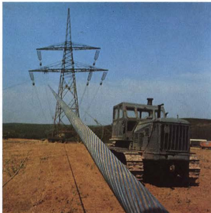
Freileitung aus Aluminium-Stahl
