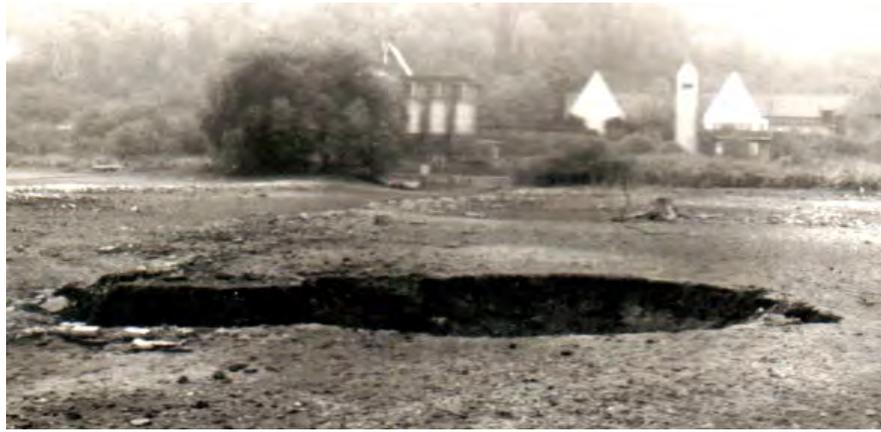
Abb. 14: Erdfall im wasserlosen Stausee, im Hintergrund Gebäude des ehem. Vorwerks
