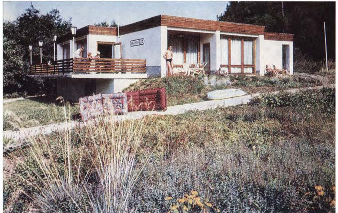
Bungalows im Naherholungszentrum Vatterode
