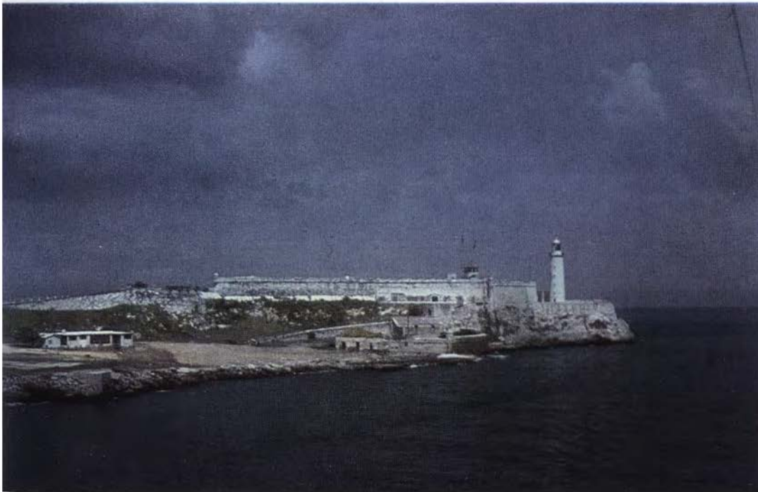
In der Republik Kuba wird das RGW-Integrationsobjekt Nickel- hütte Las Camariocas errichtet. Der VEB Industrieanlagen Dres- den exportiert dafür Ausrüstun- gen.
