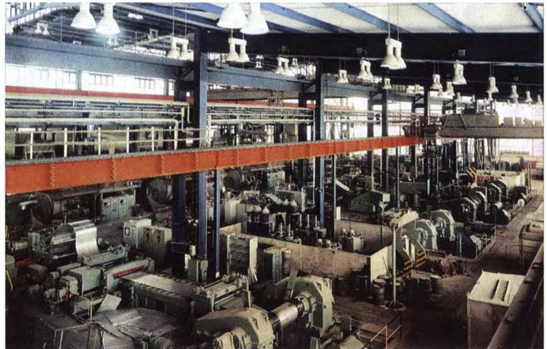
Breitbandgießwalzanlagen VEB Leichtmetallwerk Nachterstedt
