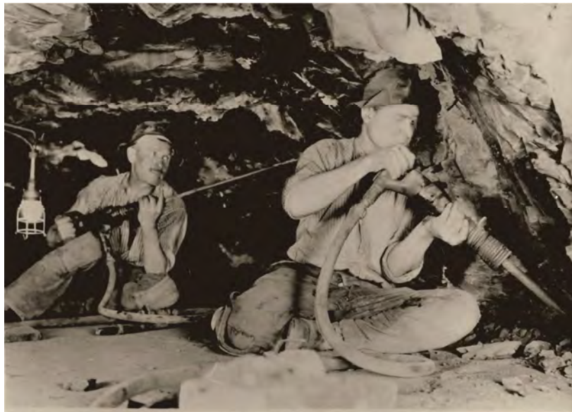
Abb. 6: Arbeit mit druckluftbetriebenem Bohr- (links) und Abbauhämmer. Foto Archiv Mansfeld Museum, Hettstedt.
