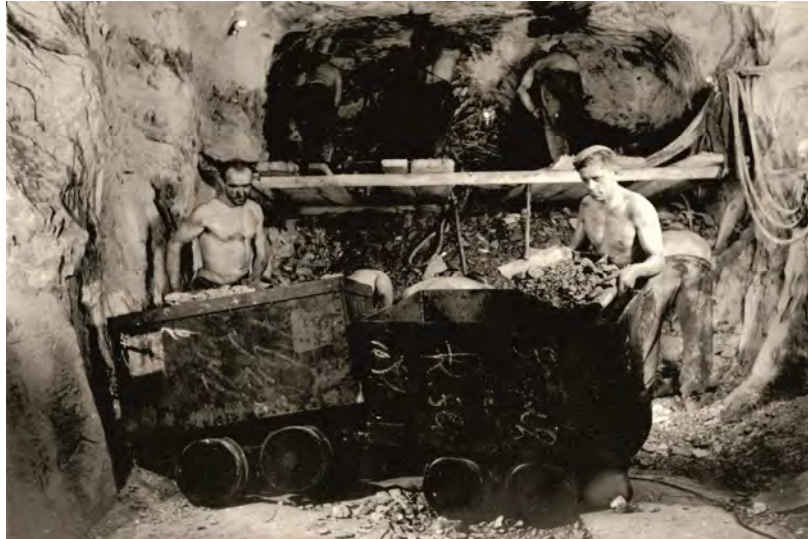
Abb. 10 und 11: Schultergeführte Bohrstütze (oben) und Ladearbeit mit Kratze und Fülltrog. Fotos Archiv Mansfeld Museum, Hettstedt.
