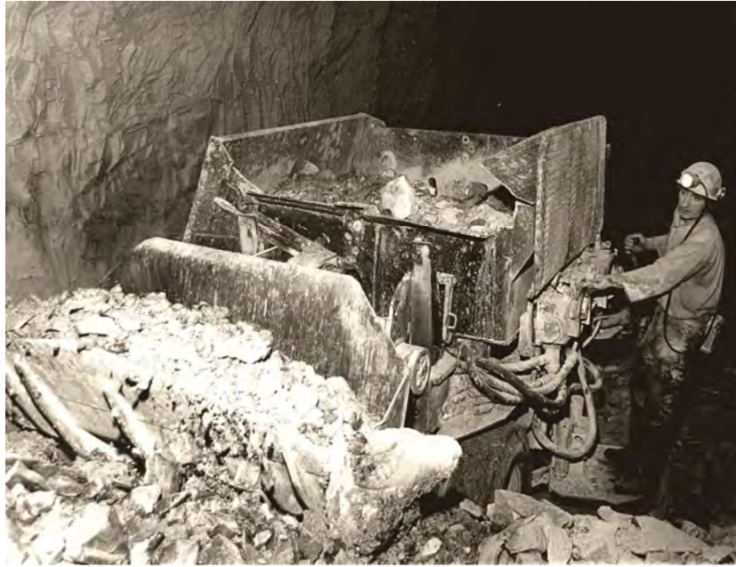
Abb. 12 und 13: Bohrwagen im Streckenvortrieb auf dem Thomas Münzer Schacht (oben) und Bunkerlader im Einsatz. Fotos Archiv Mansfeld Museum, Hettstedt.
