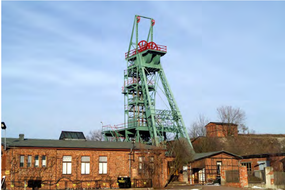
Abb. 14: Das ErlebnisZentrum Bergbau Röhrichtschacht Sangerhausen / OT Wettelrode. Foto Stedingk.
