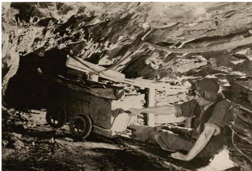
Abb. 4 und 5: Erzförderung vor Streb: Trecker im 19. Jahrhundert (oben). Im Huntrestreb mit Unterstützung durch Schlepphaspel (Clothildeschacht 1949). Fotos Archiv Mansfeld Museum, Hettstedt.
