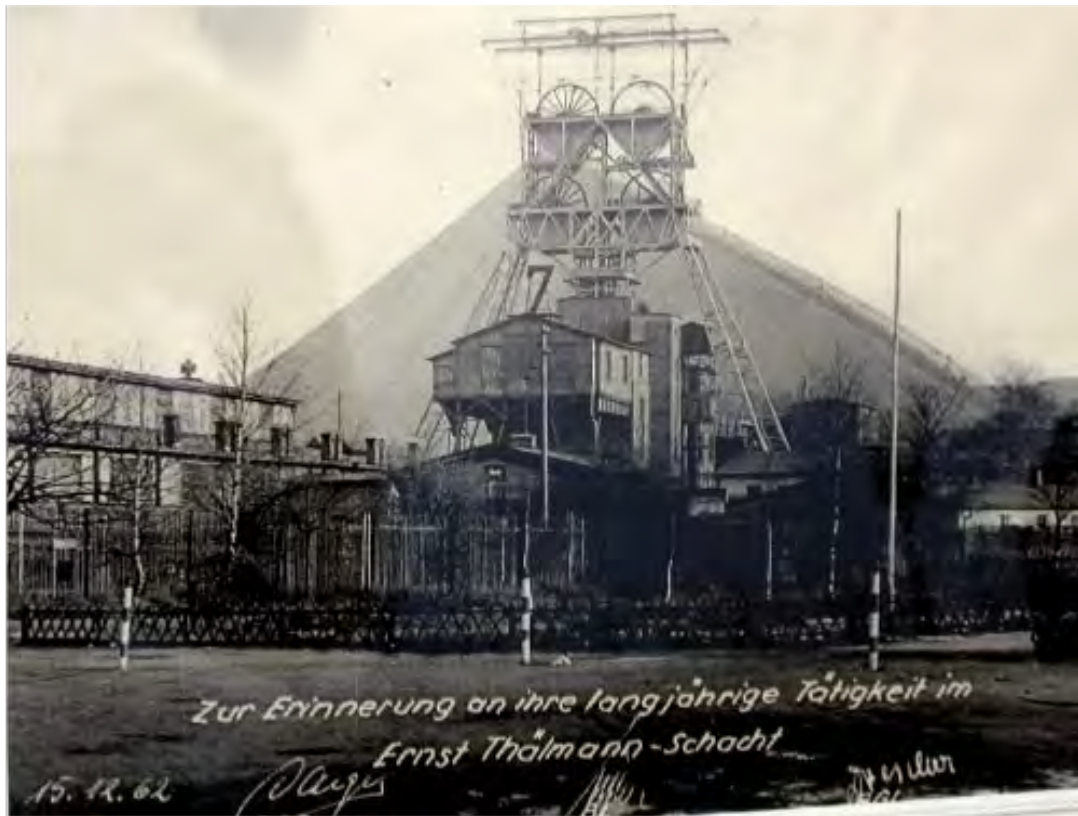
Abb. 10: Ansicht des Vitzthum-/Thälmann-Schachtes bei Polleben 1962
