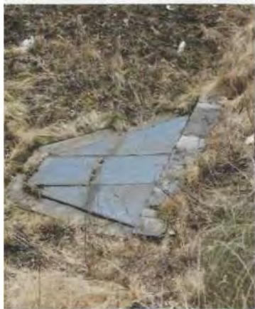
Abb. 14: Wippra, Talsperre der Wippervorsperre (2003)
