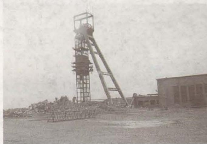
benachse bei 41,20 Meter der Ackersohle. Die Hängebank befand sich 18 Meter über der Ackersohle (+ 186 m NN). Das Fördergerüst wies ein Gesamtgewicht von etwa 315 Tonnen auf.
