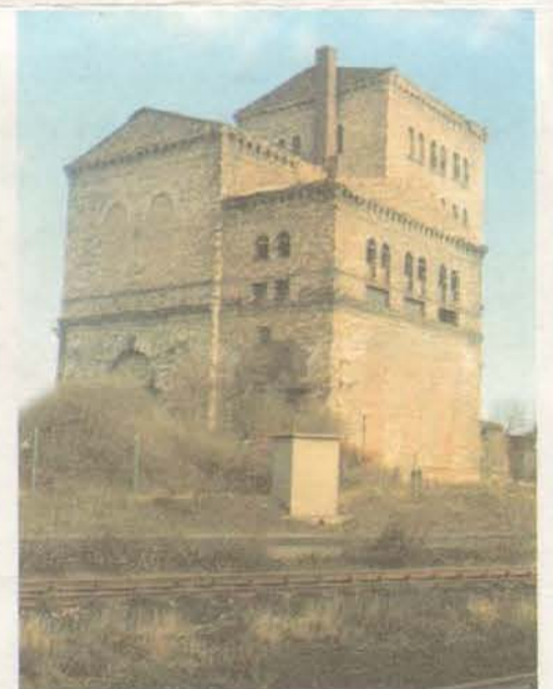
Gebäude des Wasserhaltungsschachtes Ernst-Schacht IV in Helbra.
