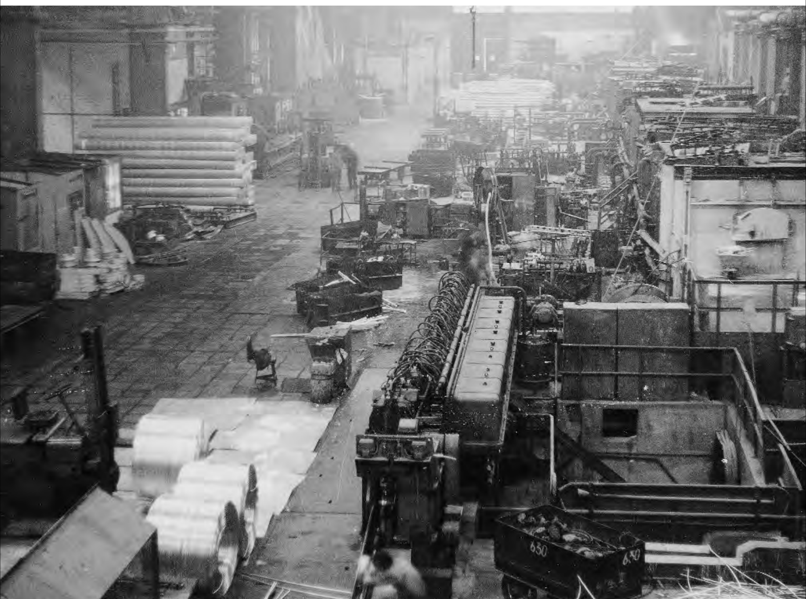
oben: Blick in die damals moderne Leichtmetallgießerei, die nach sowjetischem Vorbild (Stupino) errichtet wurde. Im Vordergrund die Drahtgießwalzanlage (Lurgi) für Aluminium-Drähte
