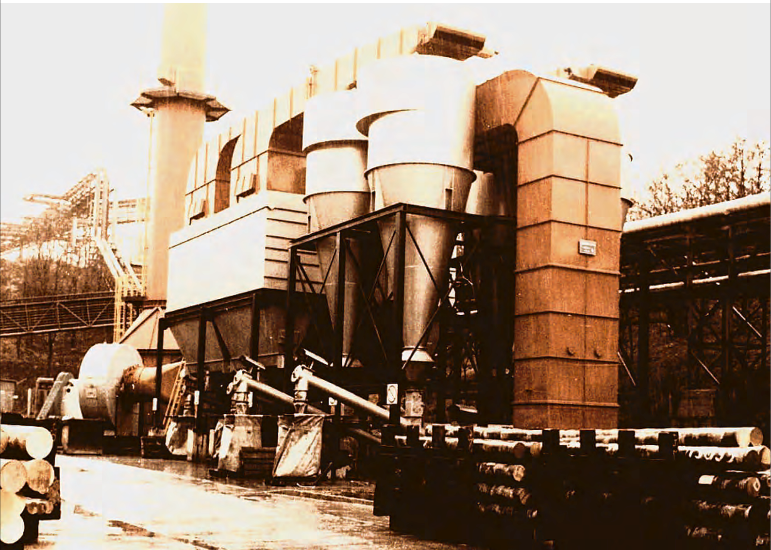
Hochwirksame Abgas-Textilfilter-Anlage SM-Schwermetallgießerei
