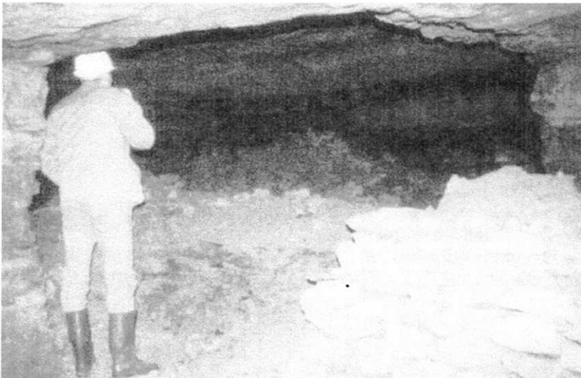
Hohlraum aus dem Abbau von Zechsteinkalk unter dem Stadtgebiet von Gerbstedt (Foto: M. Spilker, 1999)
