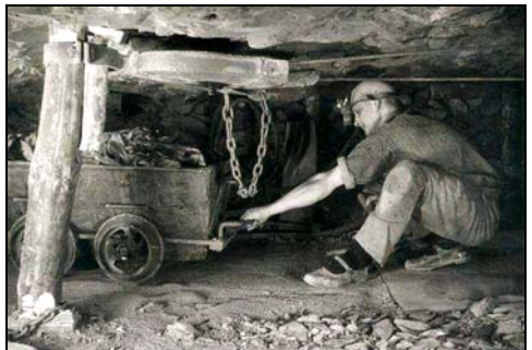
Anschlagen des Huntes an das Endlosseil des „Elektrischen Jungen“
