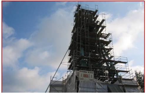
Sanierung des Fördergerüsts 2003
