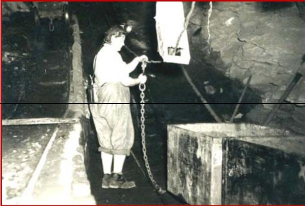
*Unterer Anschlagpunkt eines Förderflachens - Anhängen einer Förderwagendoppeltour an das Förderseil der Flachenmaschine*
