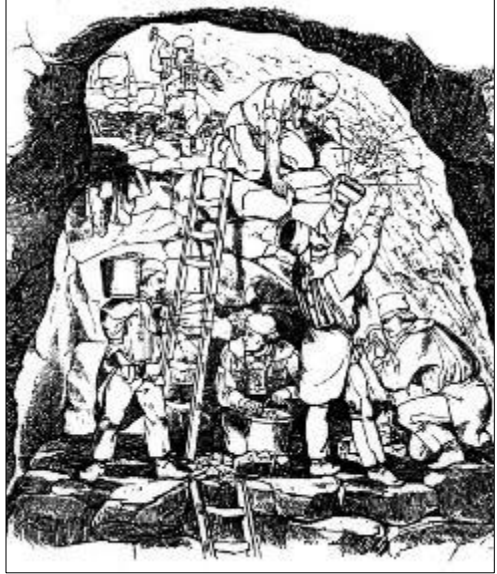
Abbauort im Firstenbau
