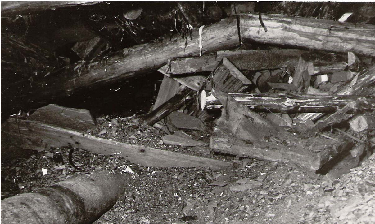
Zerstörte Rohrleitungen, angeschwemmte Schuttmassen im östlichen Brosowskischächter Flachen unterhalb der 7.Sohle.
