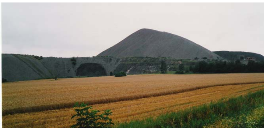
Ansicht der Schachthalde von Heiligenthal kommend.
