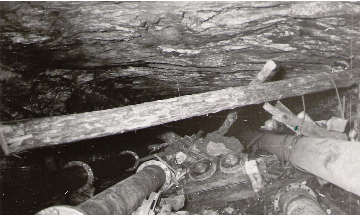
Blick in das östliche Brosowskischächter Hauptflachen. In dem Flachen waren die Rohrleitungen der Hauptwasserhaltung verlegt. Es fand keine Förderung statt. Der Förderwagen war aus der Sohle in das Flachen gespült.
