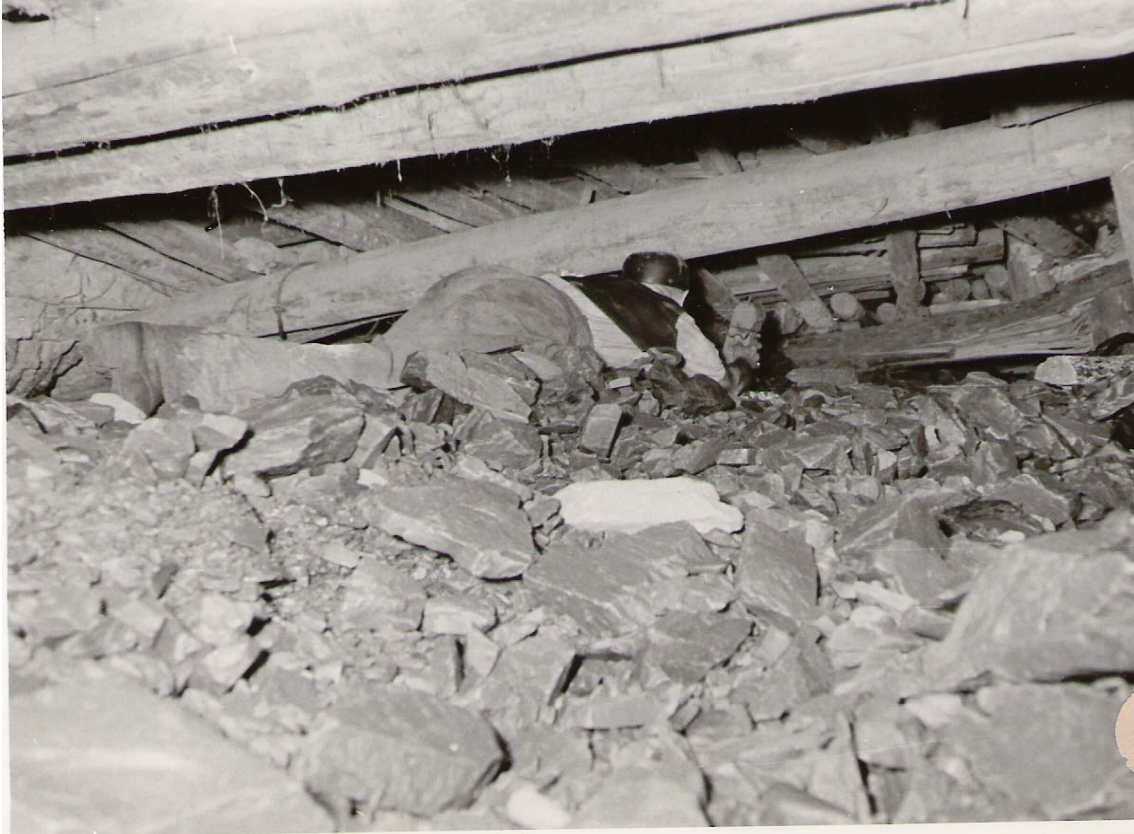
Zugspülter Sohlenabschnitt der 10. Sohle nördlich des Brosowskischächter Hauptflachen.
